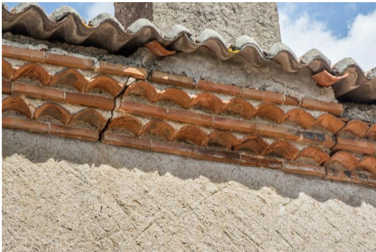
Génoise à alternance de tuiles et briques. La Barillère, Mouzillon.
