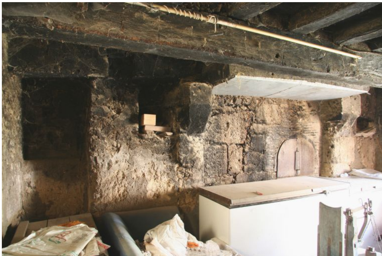
Maison 1723, pignon sud : cheminée.
