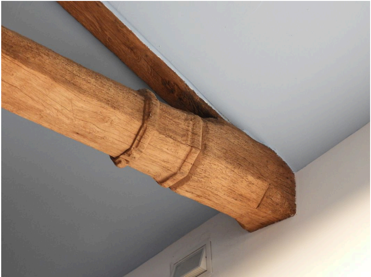
Extrémité moulurée d'un entrain.
