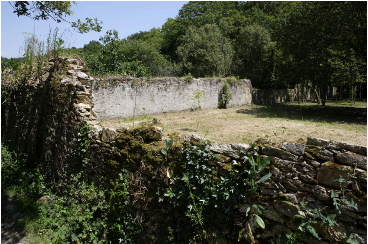
Vue du mur de clôture.
