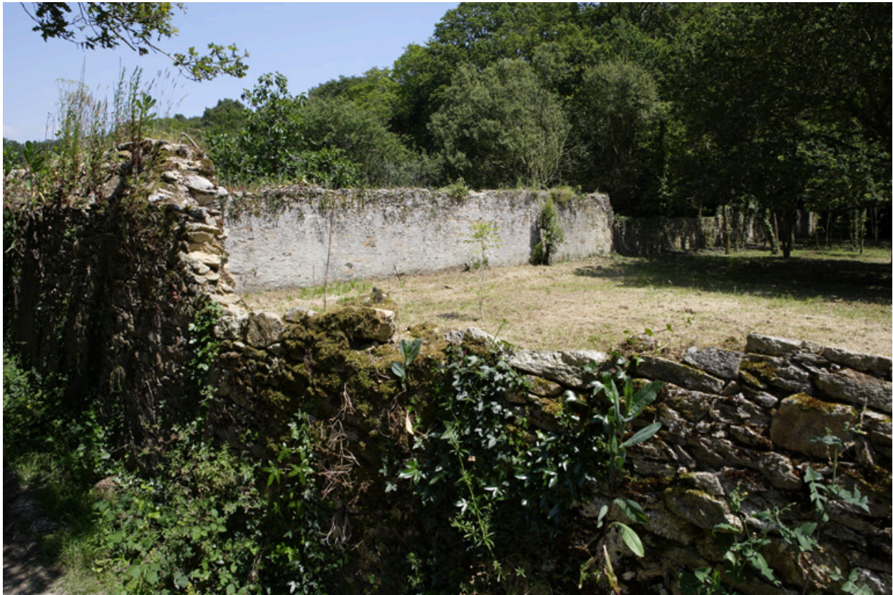
Vue du mur de clôture.
