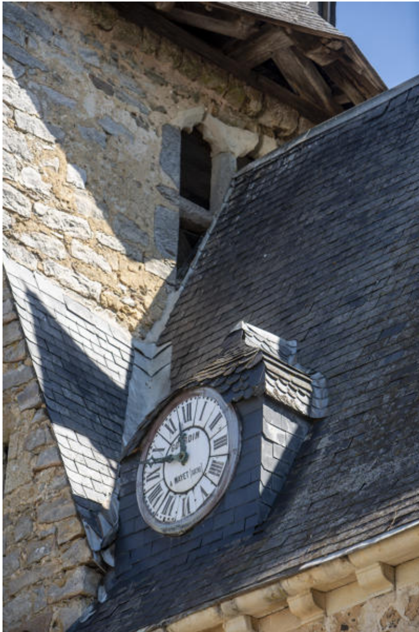
Détail du toit du bas-côté sud et de la tour de l'église Notre-Dame.
