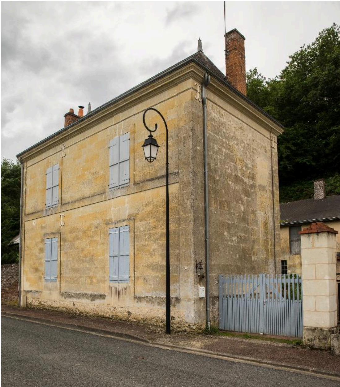
24, rue de la Vallée du Bourgneuf.
