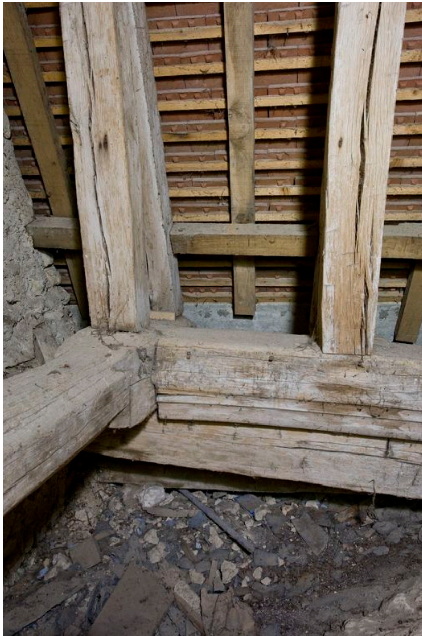
Détail des sablières moulurées de la charpente de la première travée du bas-côté nord
