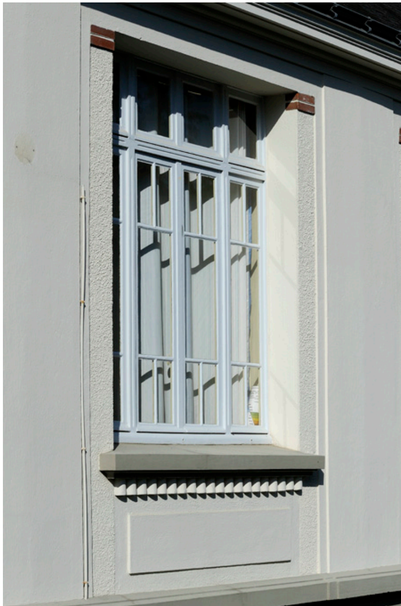
École : façade est, détail d'une baie
