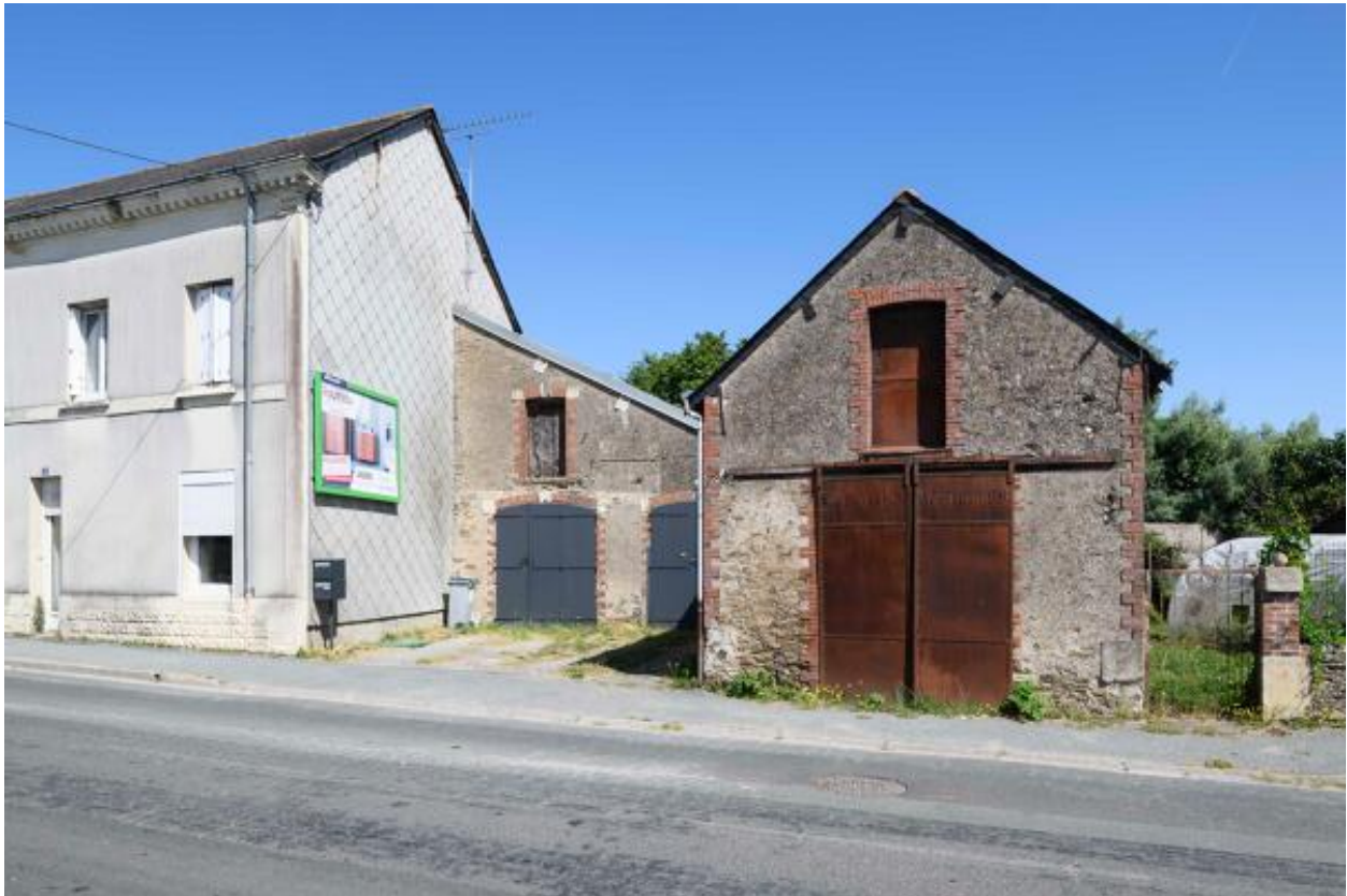
Vue d'ensemble du logis (à gauche), magasin et atelier de la forge Angebault.
