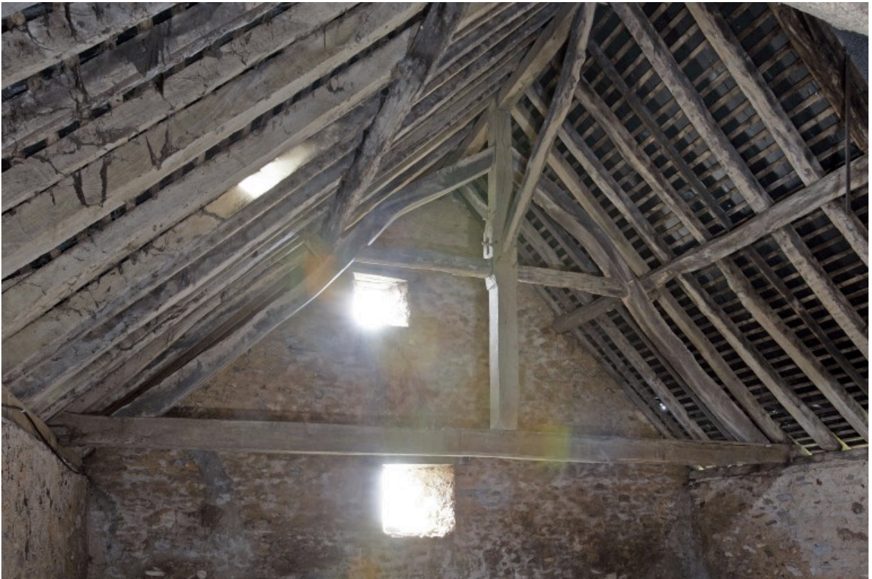
L'étable : la première ferme de charpente vue depuis le nord-est.
