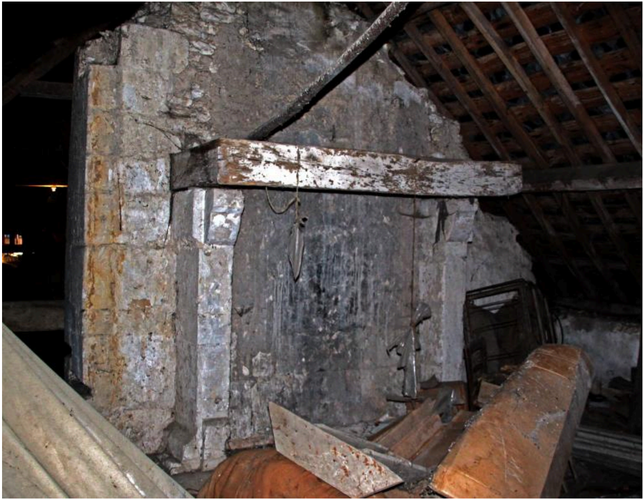
Logis, comble : cheminée (au-dessus de celle du r-d-c).
