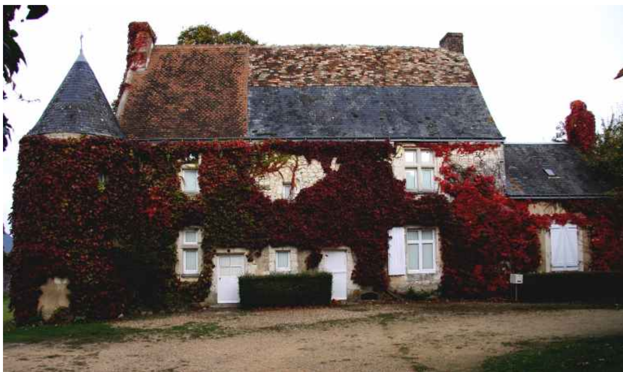
Le logis : façade antérieure.
