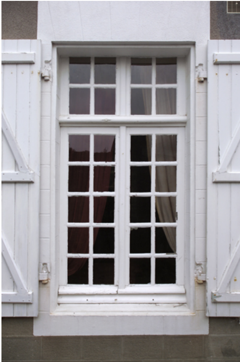
La façade antérieure détail d'une baie située au rez-de-chaussée.
