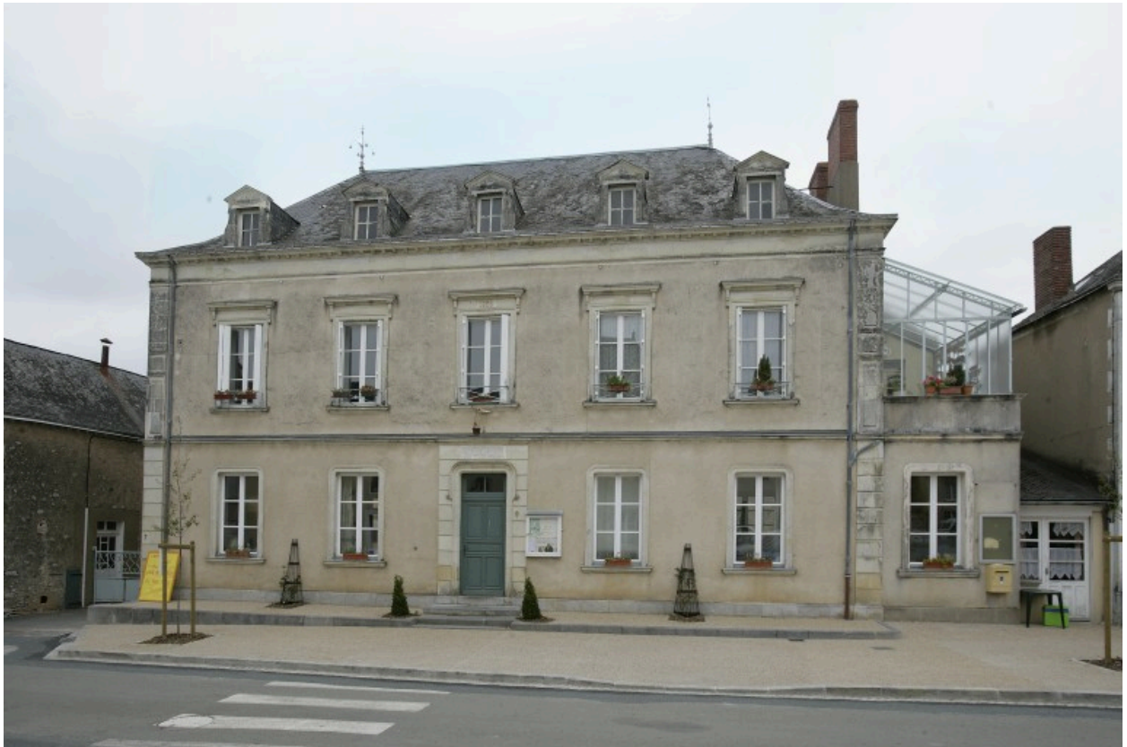
Le bâtiment principal, vu depuis la rue au sud-ouest.
