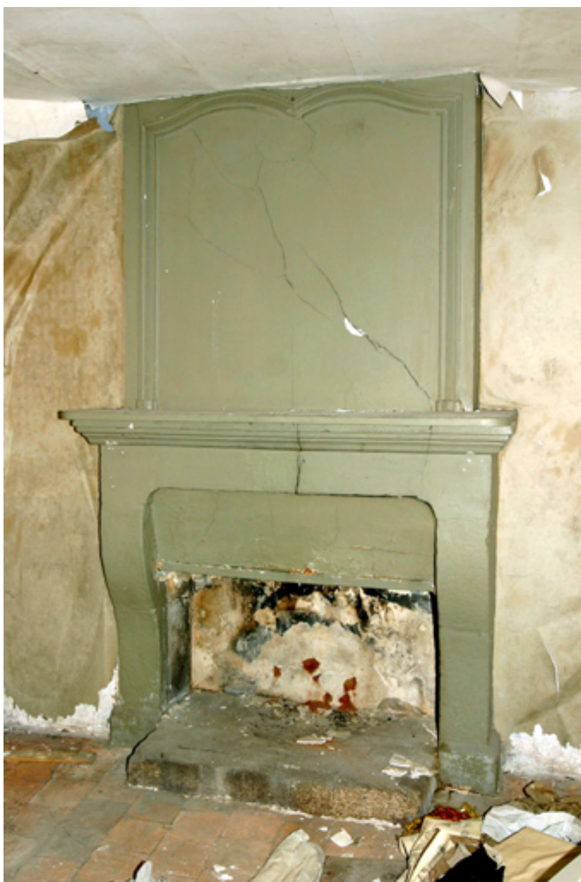
Cheminée à l'étage de comble de l'aile nord, salle ouest.
