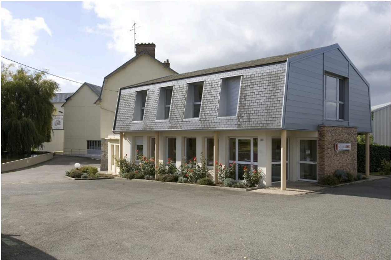
Les bureaux vus depuis le nord-est.
