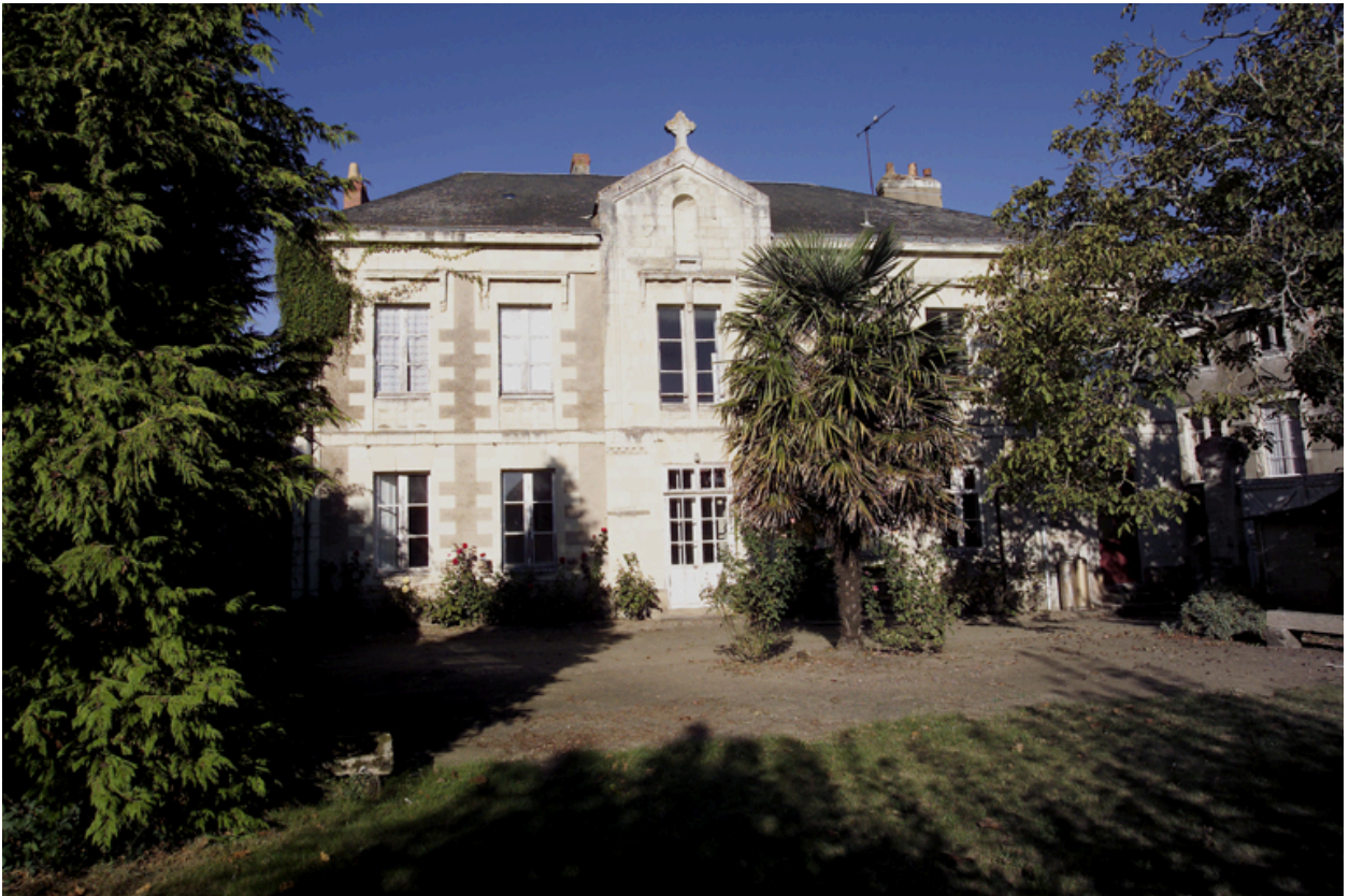
La façade postérieure.
