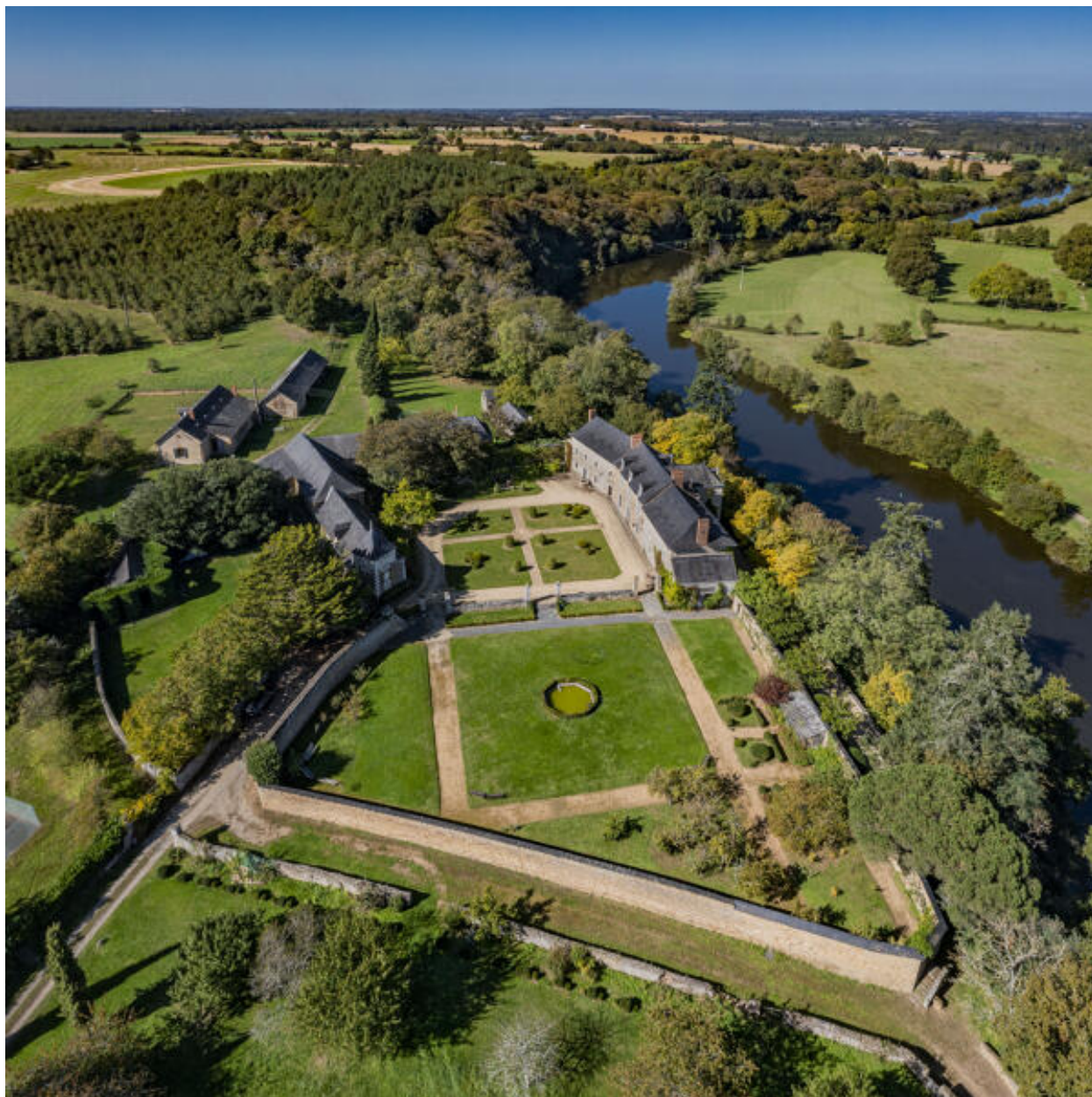
Une vue aérienne du sites des Vaux.
