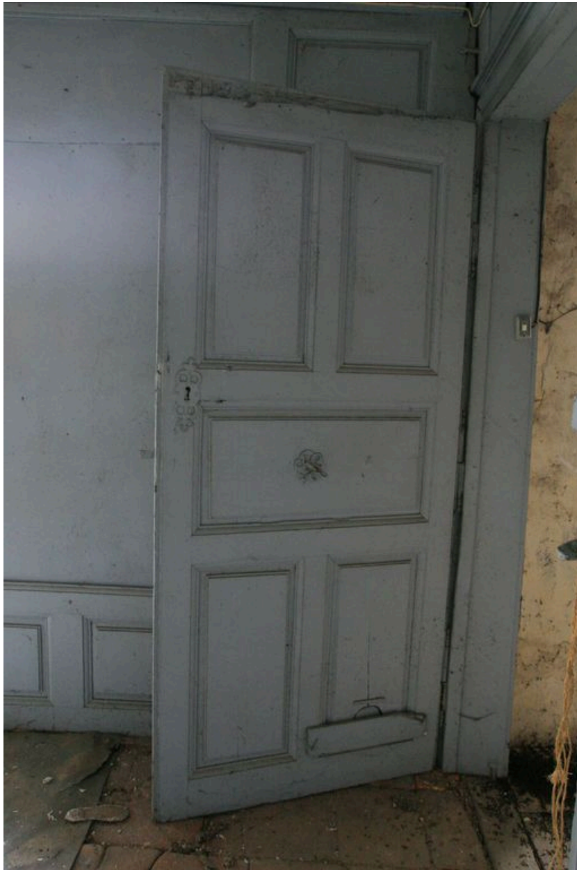
1er étage : menuiserie de la porte de l'escalier.
