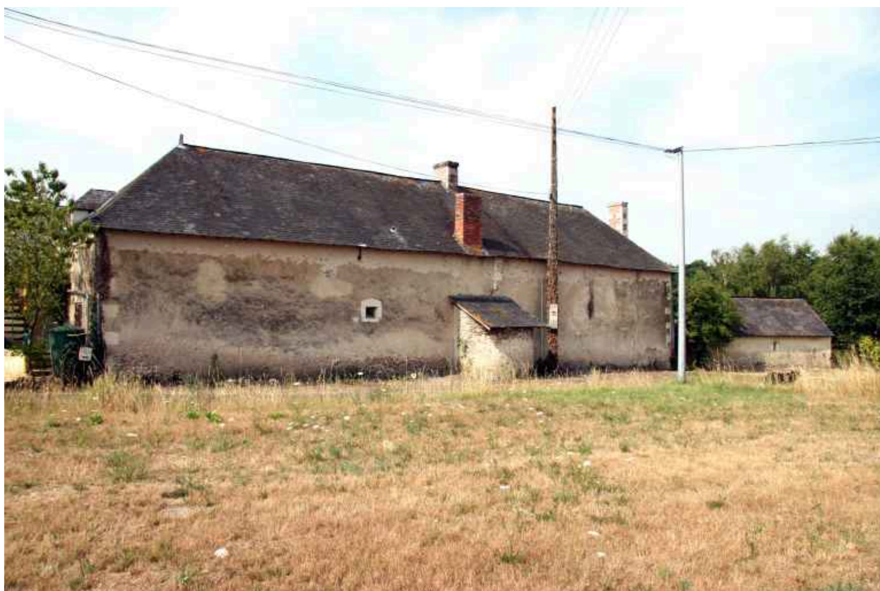
Façade postérieure sur le chemin.
