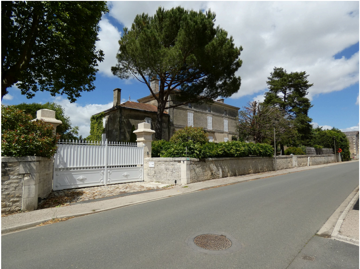
La propriété vue depuis le sud-ouest.
