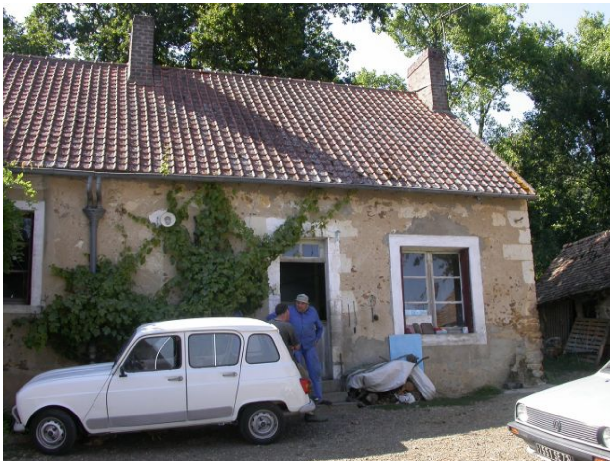
La maison : couverture récente et baies remaniées.
