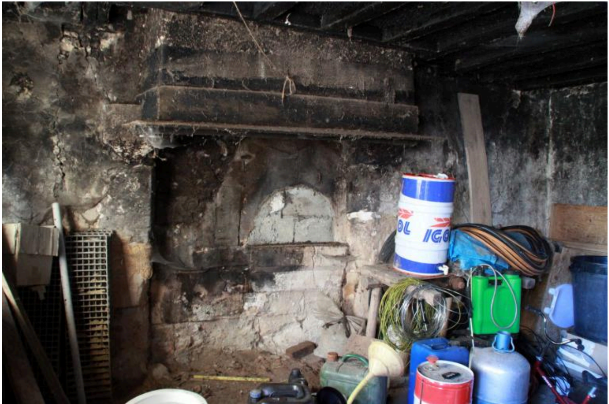
Maison désaffectée : cheminée avec vestiges de la fin du XVe siècle.
