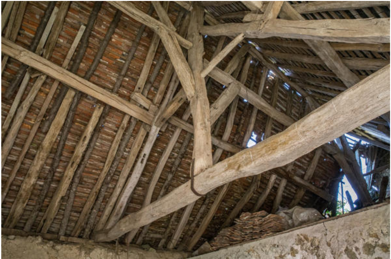
Charpente au-dessus de la grange-étable.
