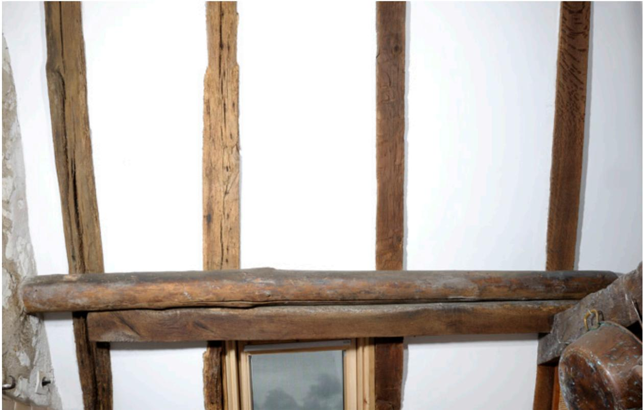
Comble : vue de la charpente, détail d'un tronçon de mat de navire de Loire en emploi comme confortement de panne.
