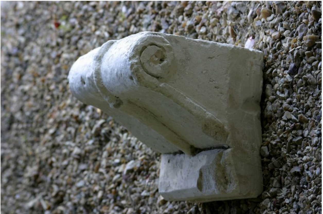
Console provenant de la démolition d'une cheminée au premier étage est.
