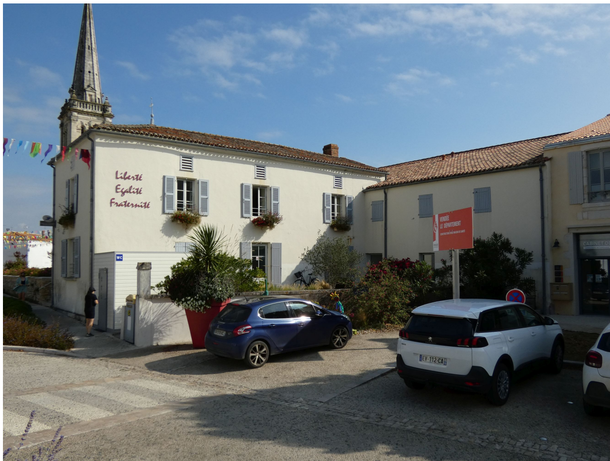
Le corps de bâtiment ouest et son aile en retour d'équerre, vus depuis le sud-ouest.
