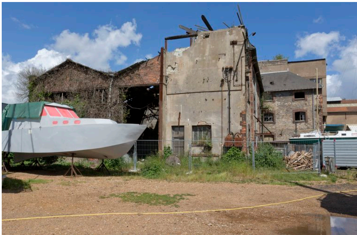
A : partie sud du bâtiment A.
