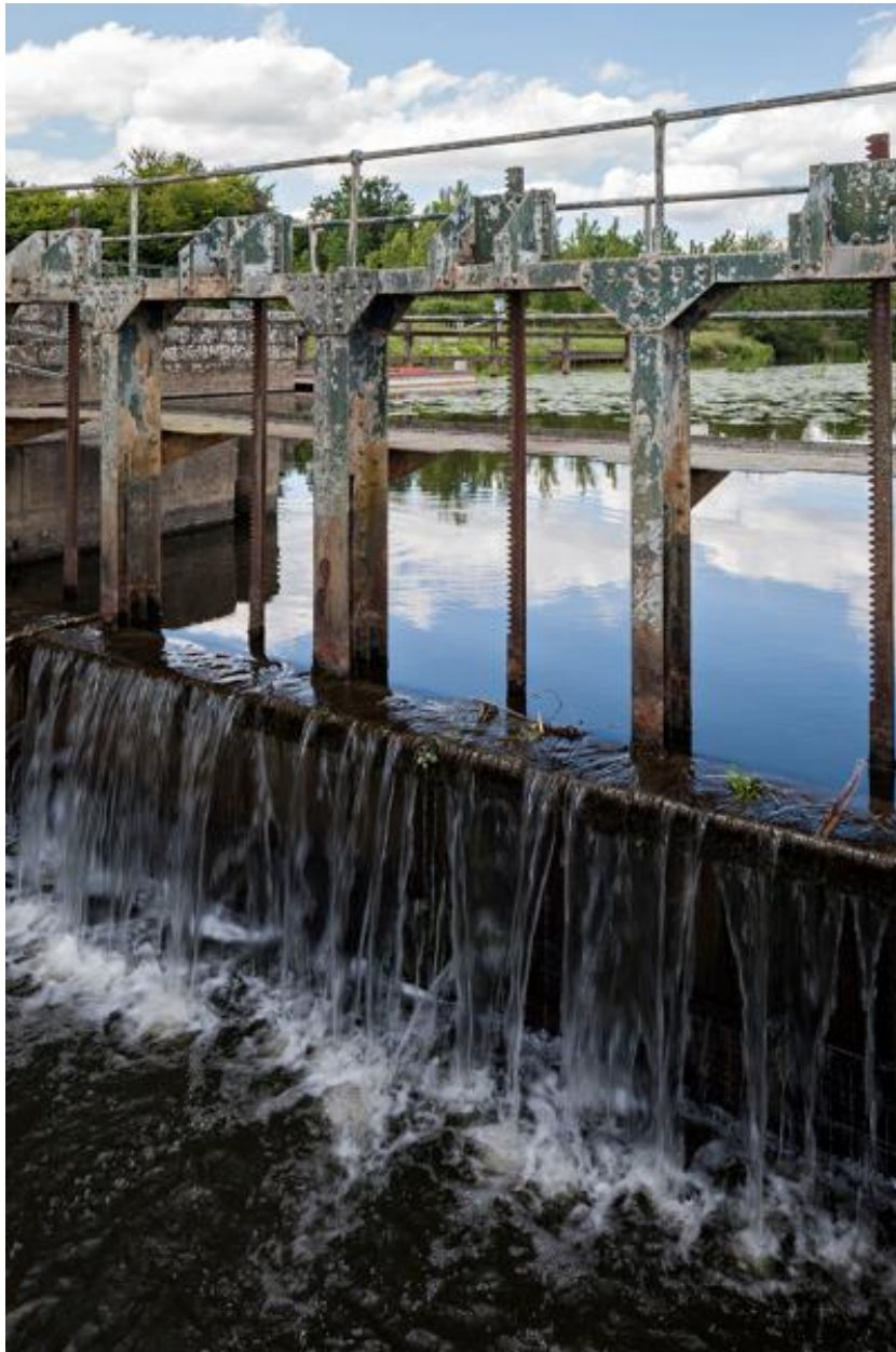
Vue rapprochée du pertuis depuis l'aval, au sud-est.
