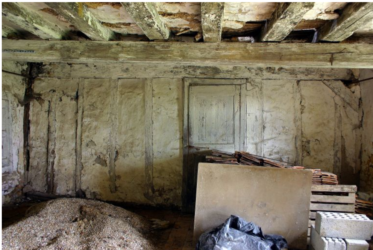
Maison 1 : cloison en pan de bois.
