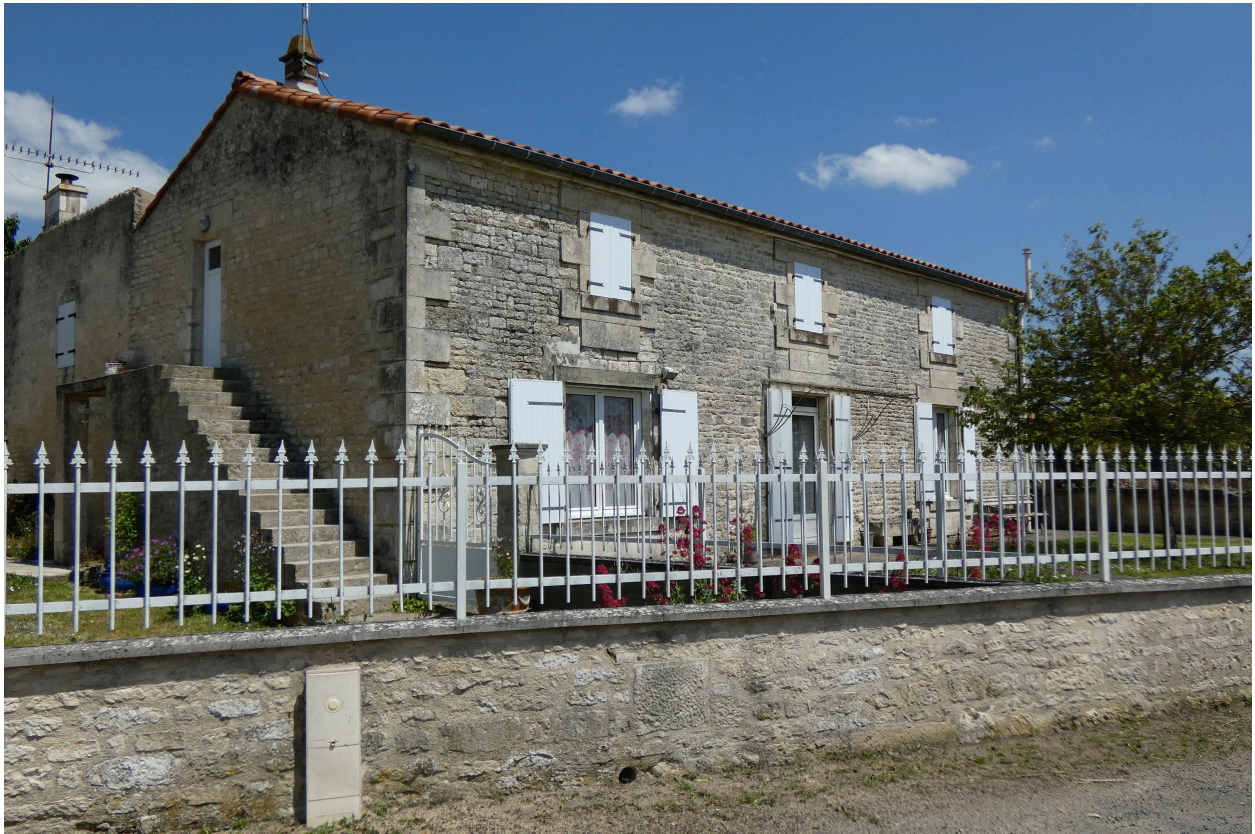
Le logis et son escalier extérieur vus depuis l'ouest.
