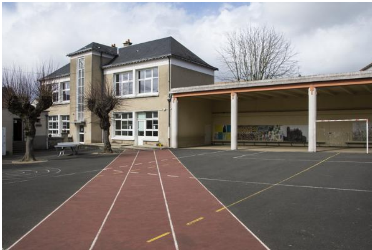
Vue du bâtiment en fond de cour et du préau.
