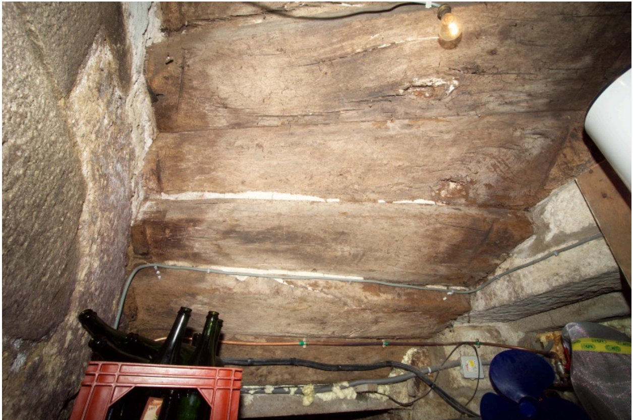
Détail du revers des marches entre le rez-de-chaussée et la cave.
