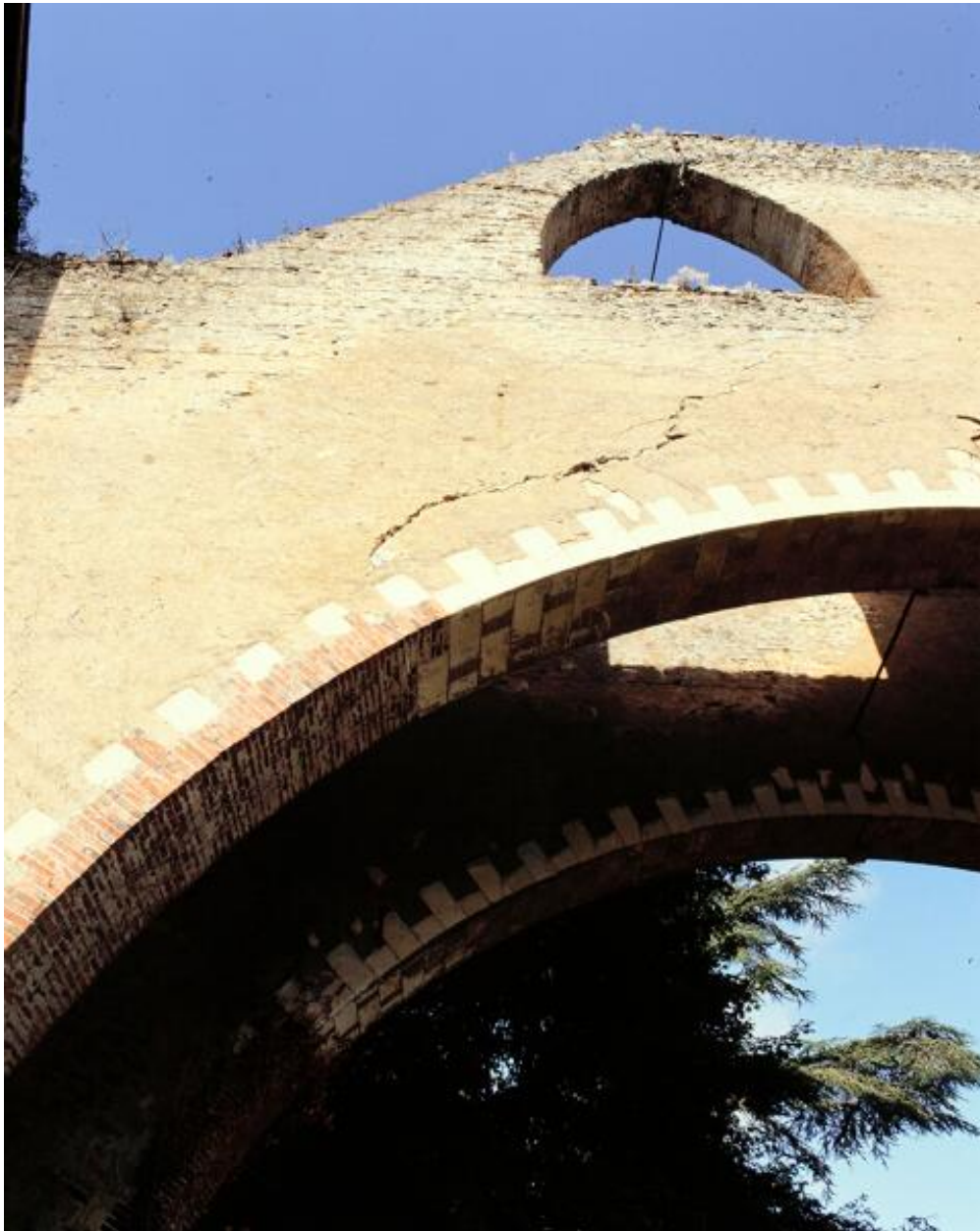
Détail, de bas en haut, du chevalement du puits de la Tranchée, fours de la Tranchée, Montjean-sur-Loire.
