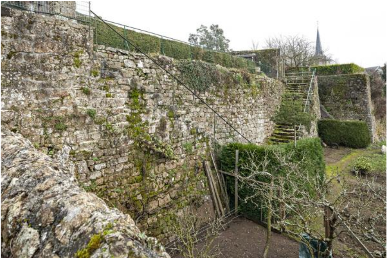
Flanc sud du bourg, murs des jardins surmontant le Lassay, sous la maison du 20 place du 8-Mai-1945.
