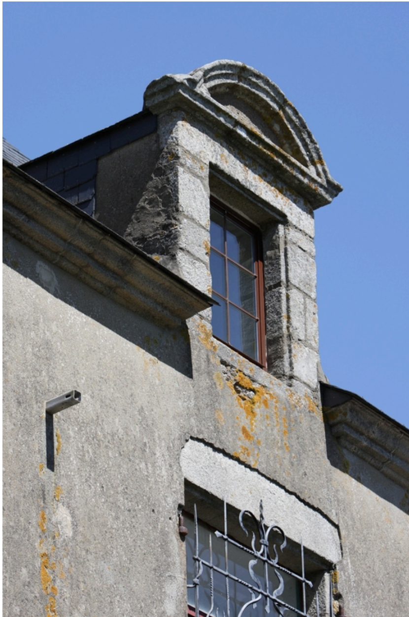
Logis. Façade sud. Détail de la cinquième lucarne.
