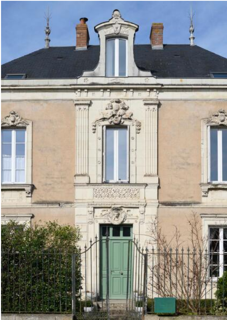
Détail de la façade principale.
