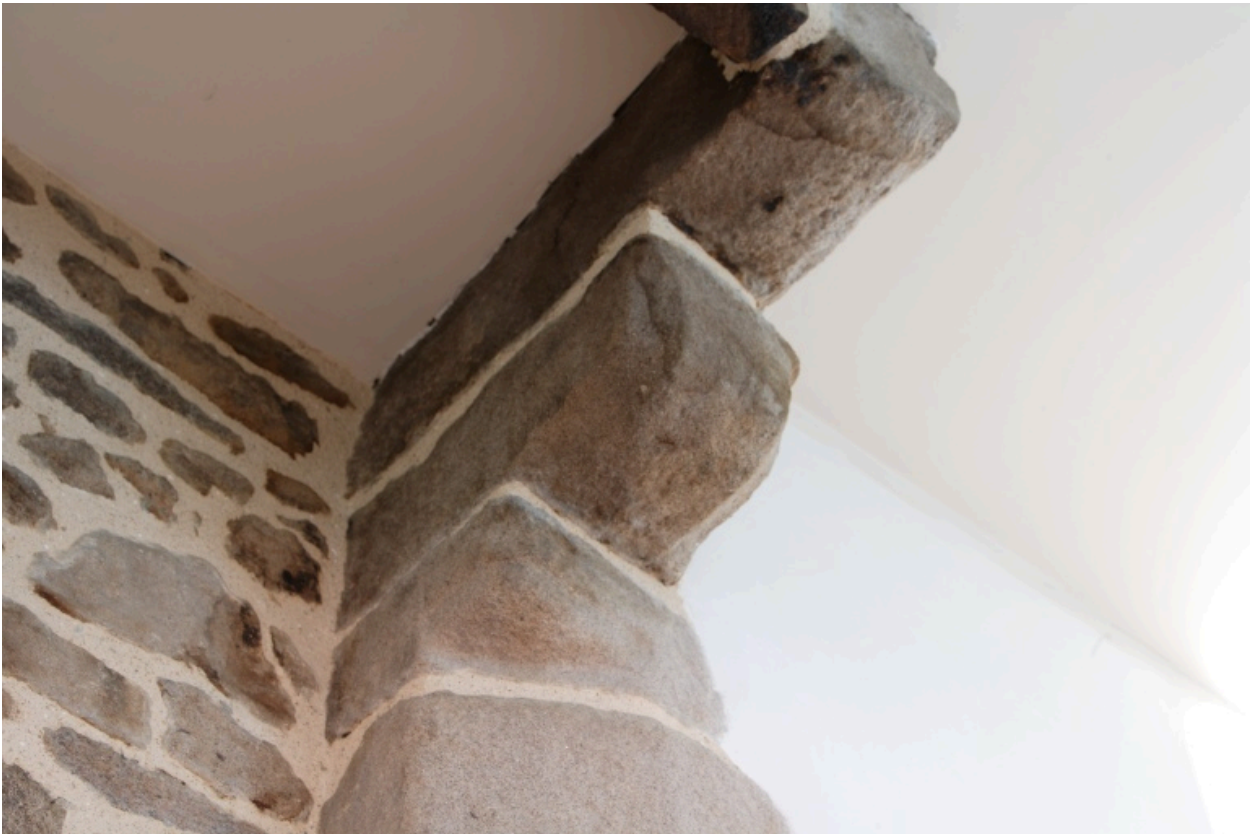
Détail de la console droite de la cheminée du 1er étage.
