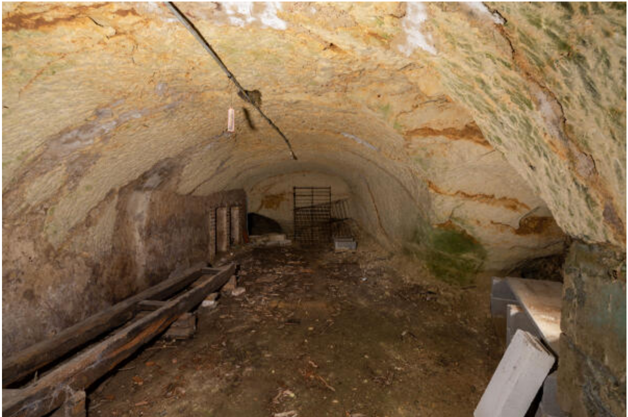
Cellier troglodytique (est) : vue intérieure.
