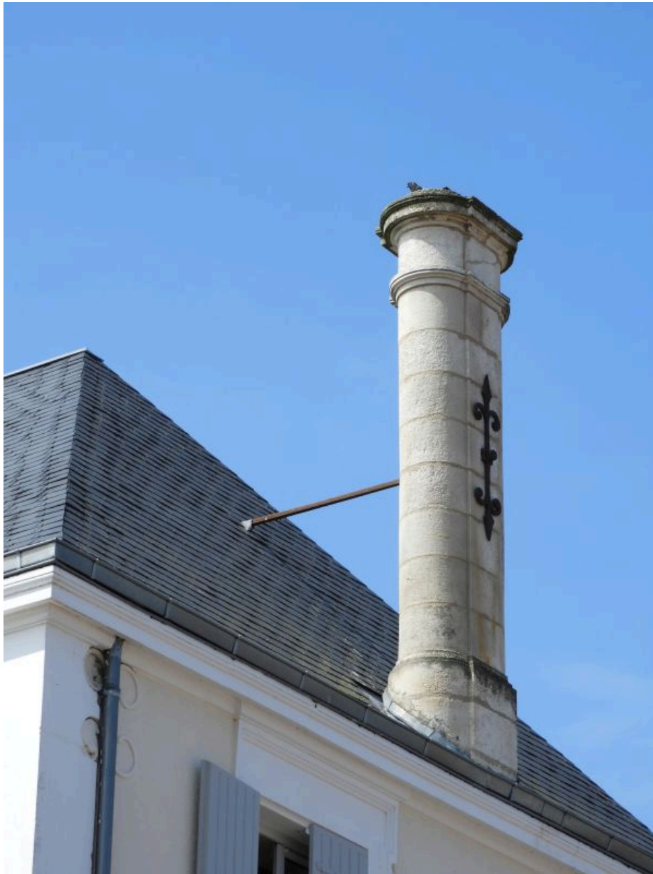
La souche de cheminée
