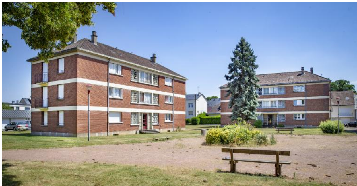
Vue des bâtiments D4 et D3 depuis les espaces verts.
