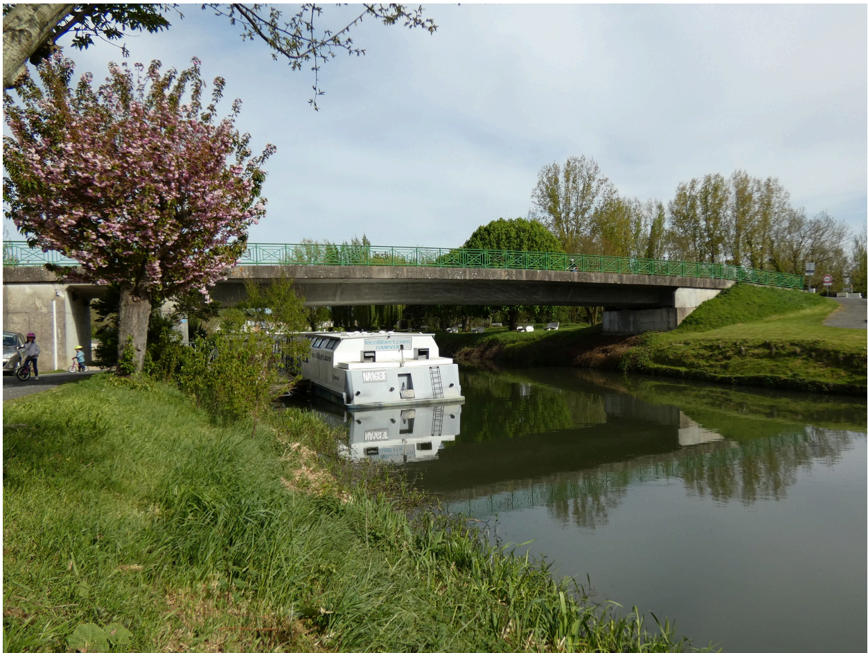
Le pont vu depuis l'ouest, côté aval.
