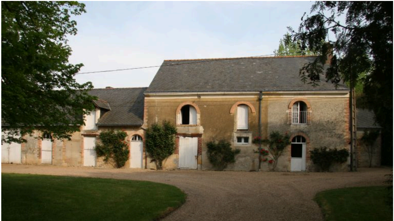
Façade antérieure sur cour.
