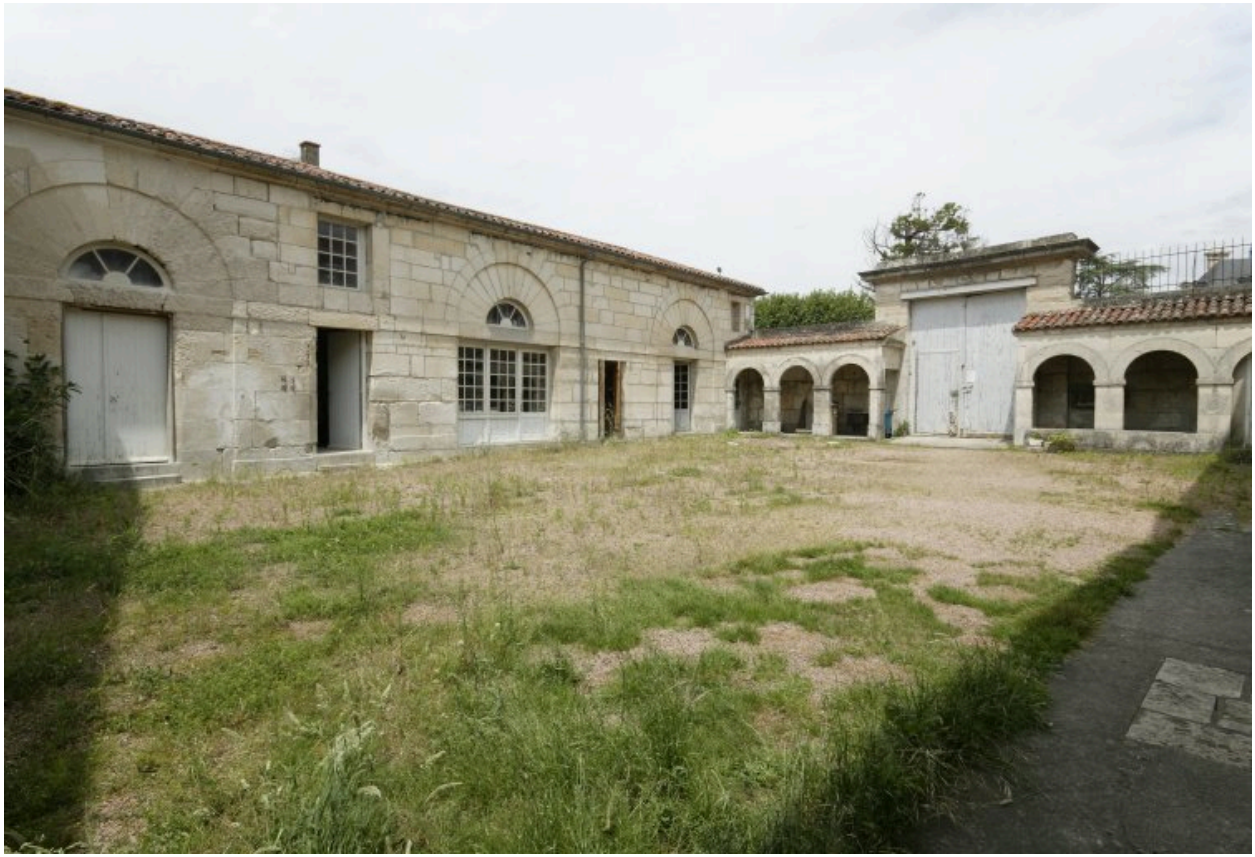
Vue des bâtiments de communs à l'ouest et au nord de la cour.
