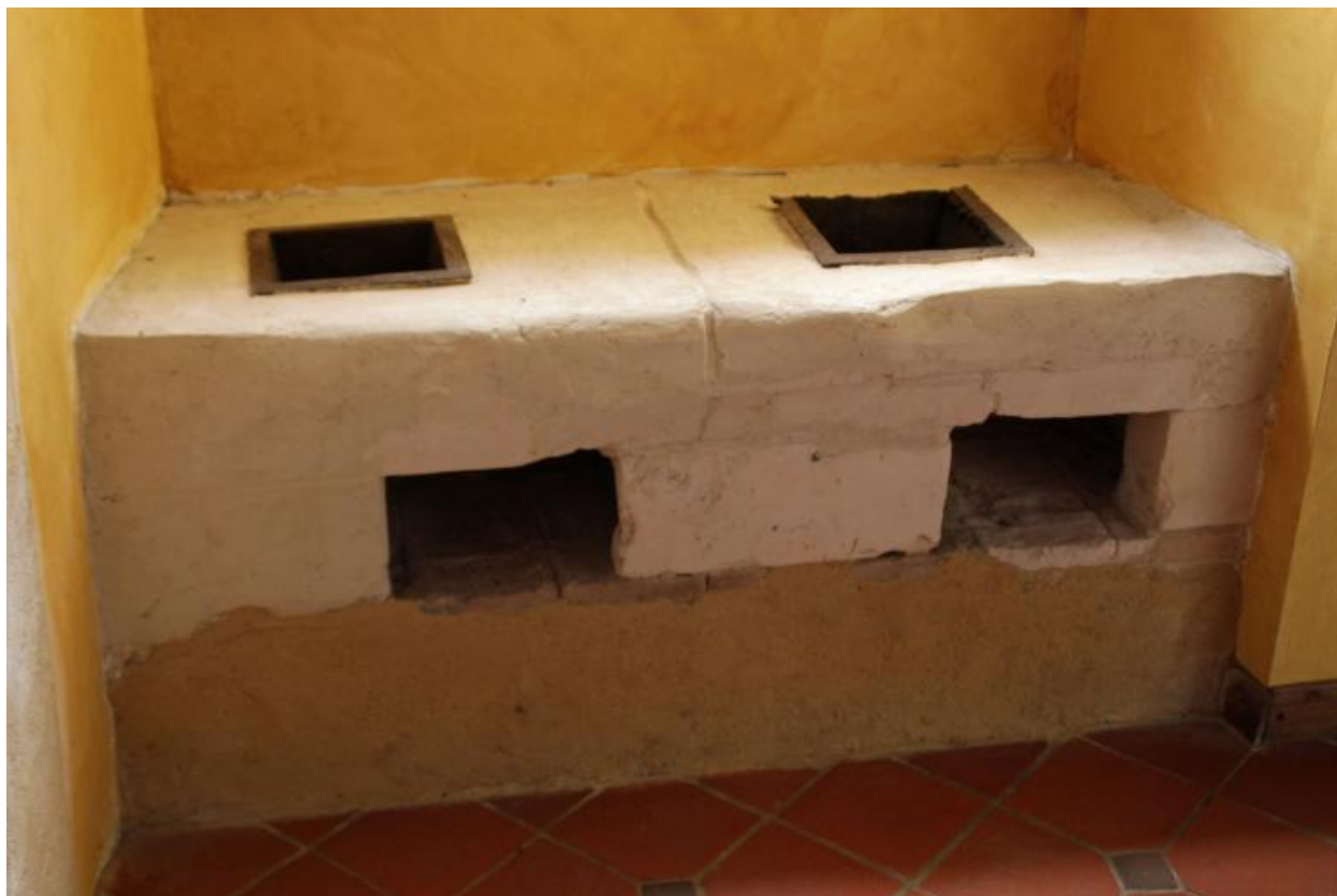
Maison, rez-de-chaussée. Potager pour maintenir les aliment au chaud.
