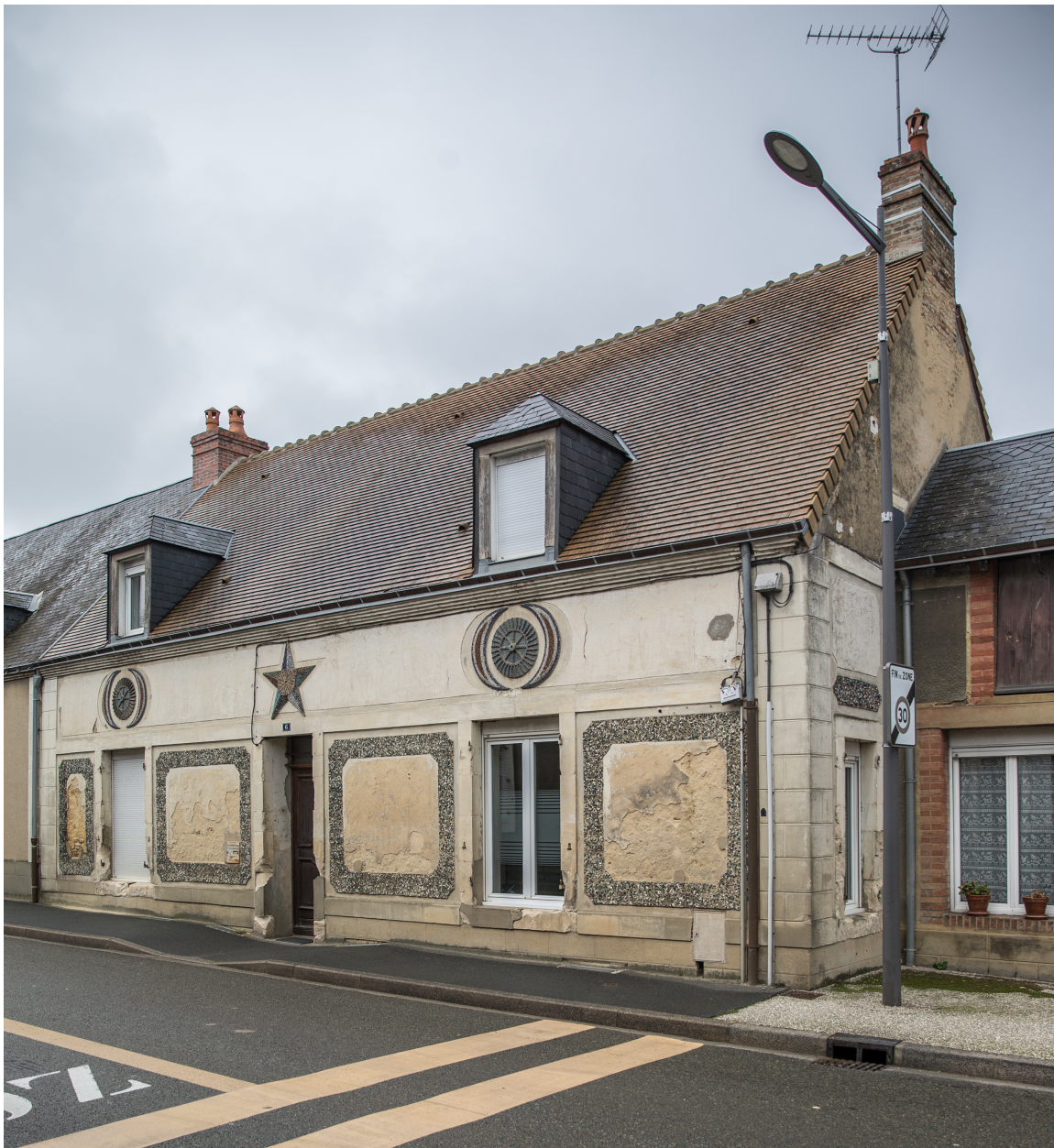
La façade principale.
