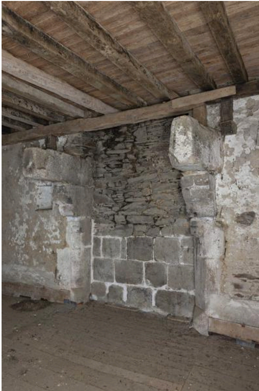
Corps de logis nord, cheminée du mur-pignon nord.
