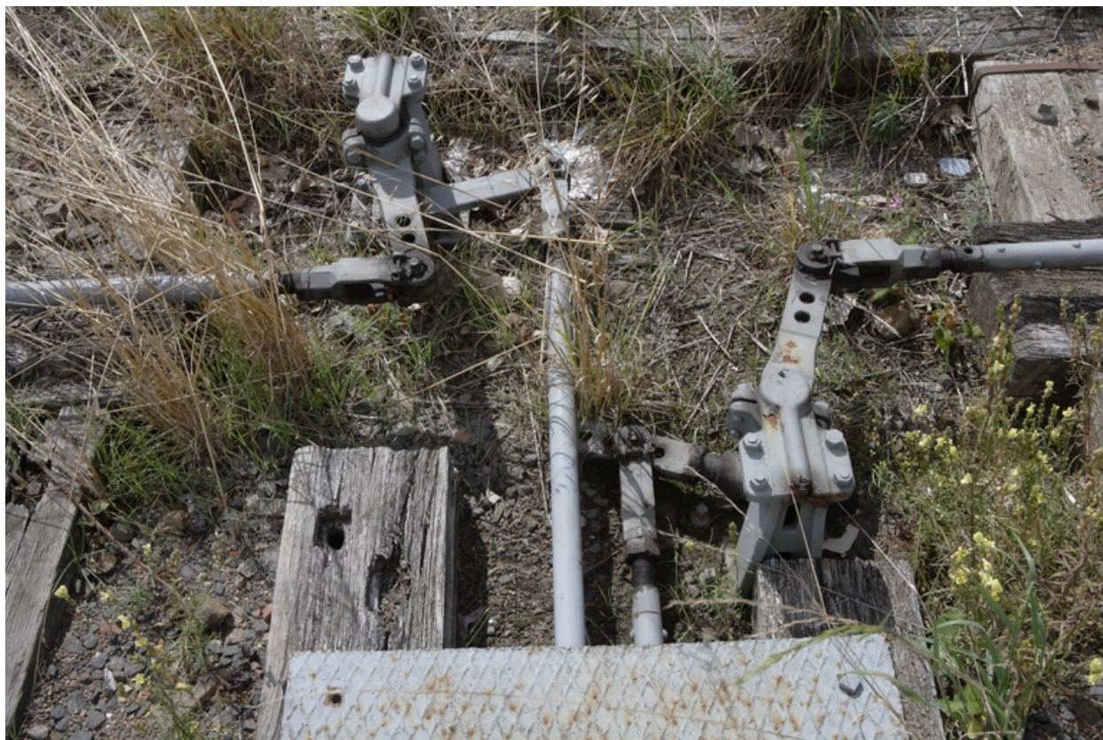
Mécanisme du levier de manoeuvre.
