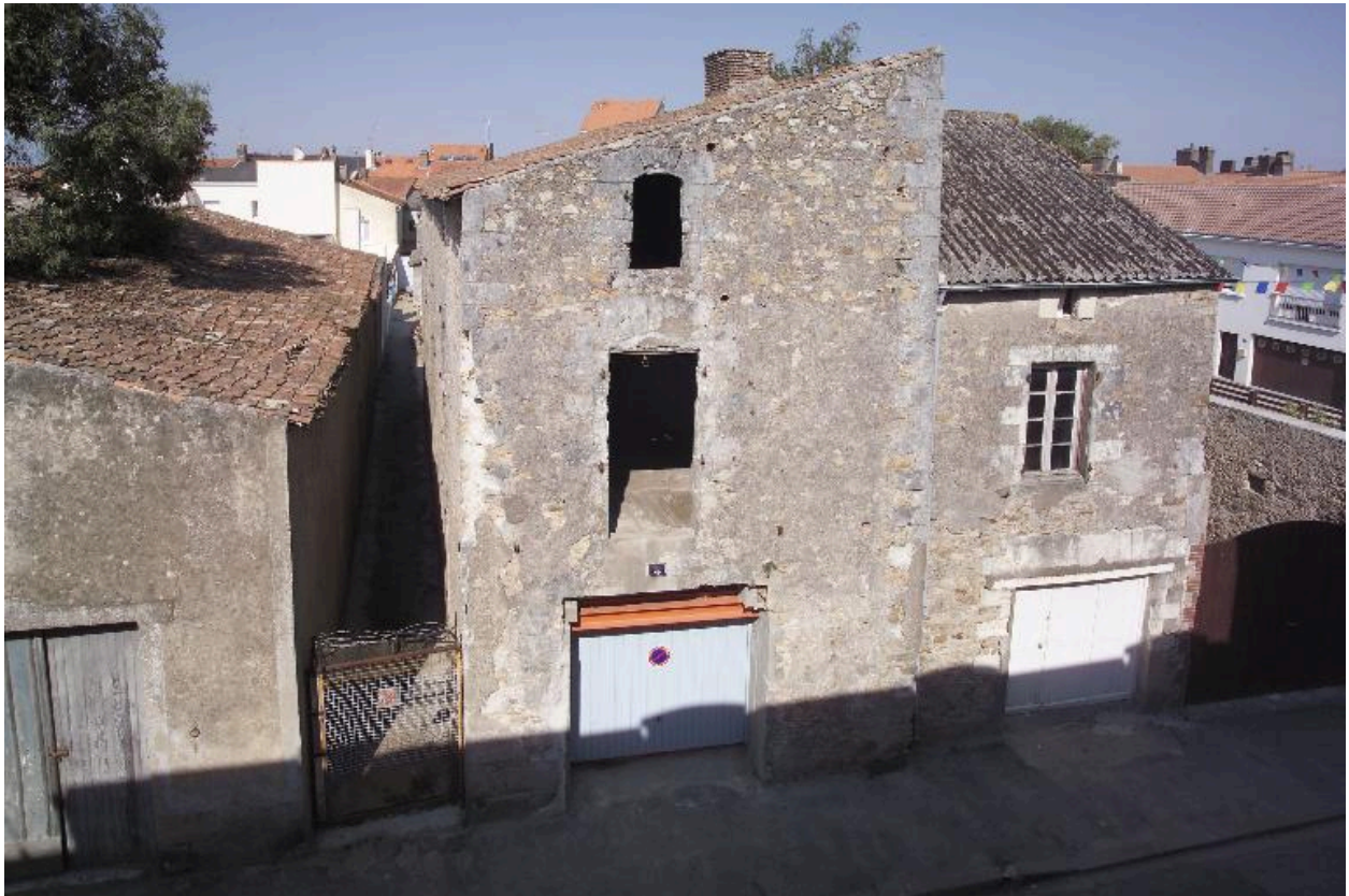
Vue de la maison n° 8 rue du Faisan depuis l'immeuble opposé.
