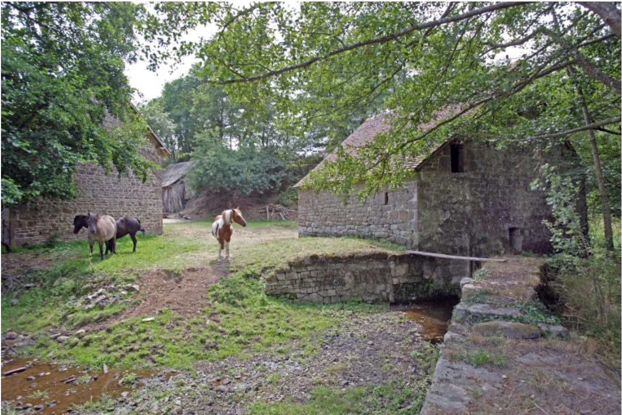
Le moulin à farine sur la Mayenne : élévations est et nord et canal d'alimentation vus depuis le barrage. A gauche, l'étable.
